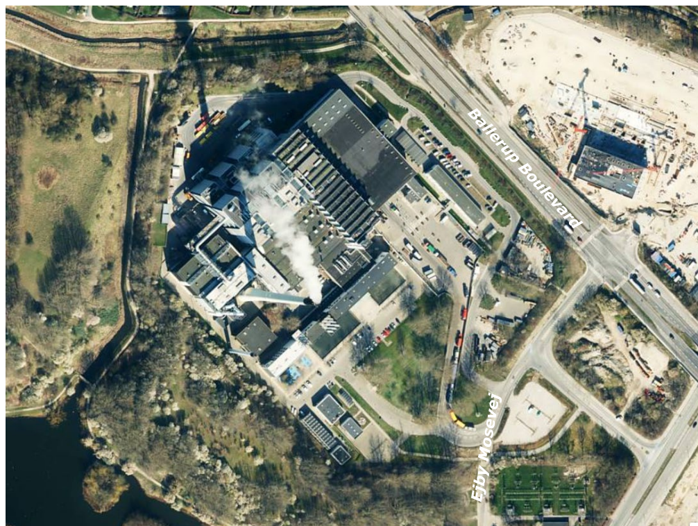
Figur 4.1: Eksisterende forhold i planområdet ved Ejby Mosevej i Glostrup.
