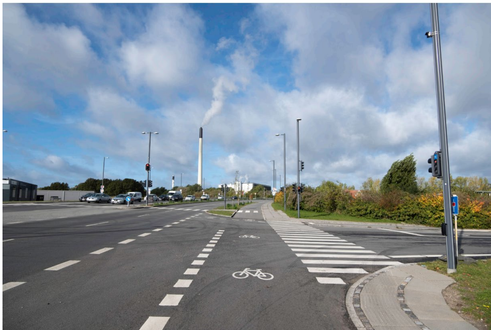
Figur 13-7 Punkt O2 – eksisterende forhold – set fra Slotsherrensvej mod sydøst.
